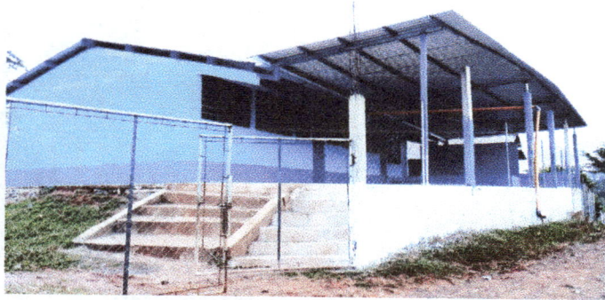
Foto1: Vista panorámica Frontal del estado actual del Edificio Escolar.
