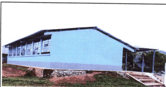
Foto 4: Vista Lateral de lado Oeste del Edificio Escolar
